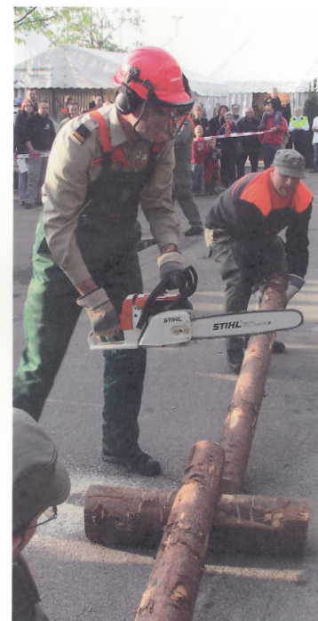
Zivilschützer sägen Stützen zurecht für das einsturzgefährdete Haus.
