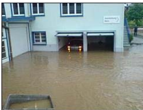
In Fraubrunnen steht die Möbelfabrik unter Wasser. (Bild: Mobile-Reporter M. Kuoni).
